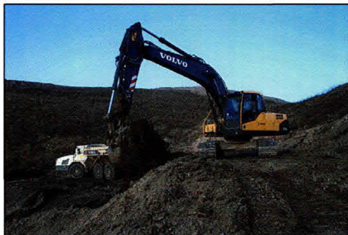
Abtragen der Bermen um an den Fußpunkt der Versackung zu gelangen (Bild 4)
