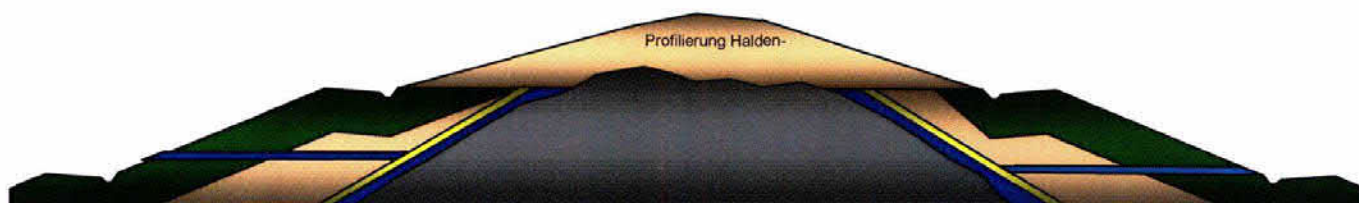
Profilierung Haldentop zur Abführung von Niederschlagswasser (Bild 10)
