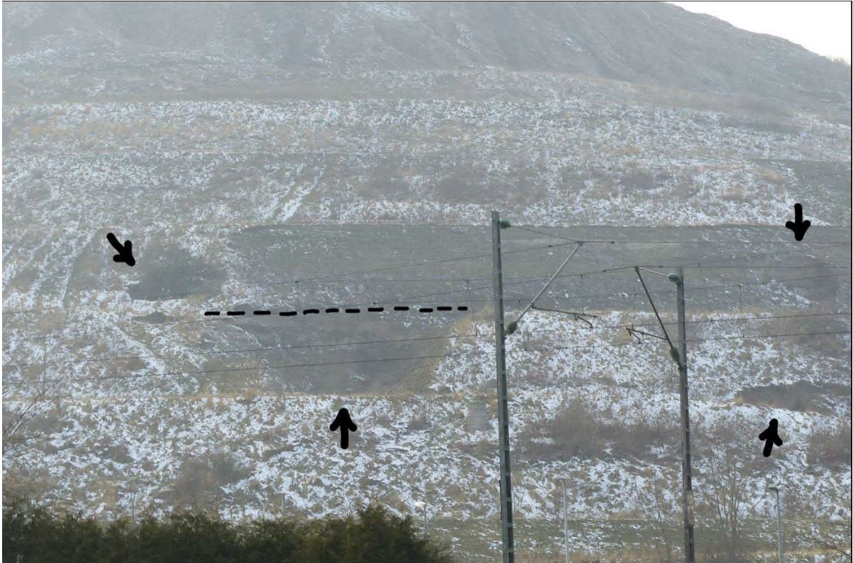
Die Pfeile weisen auf die Versackungen aus 2/2018
