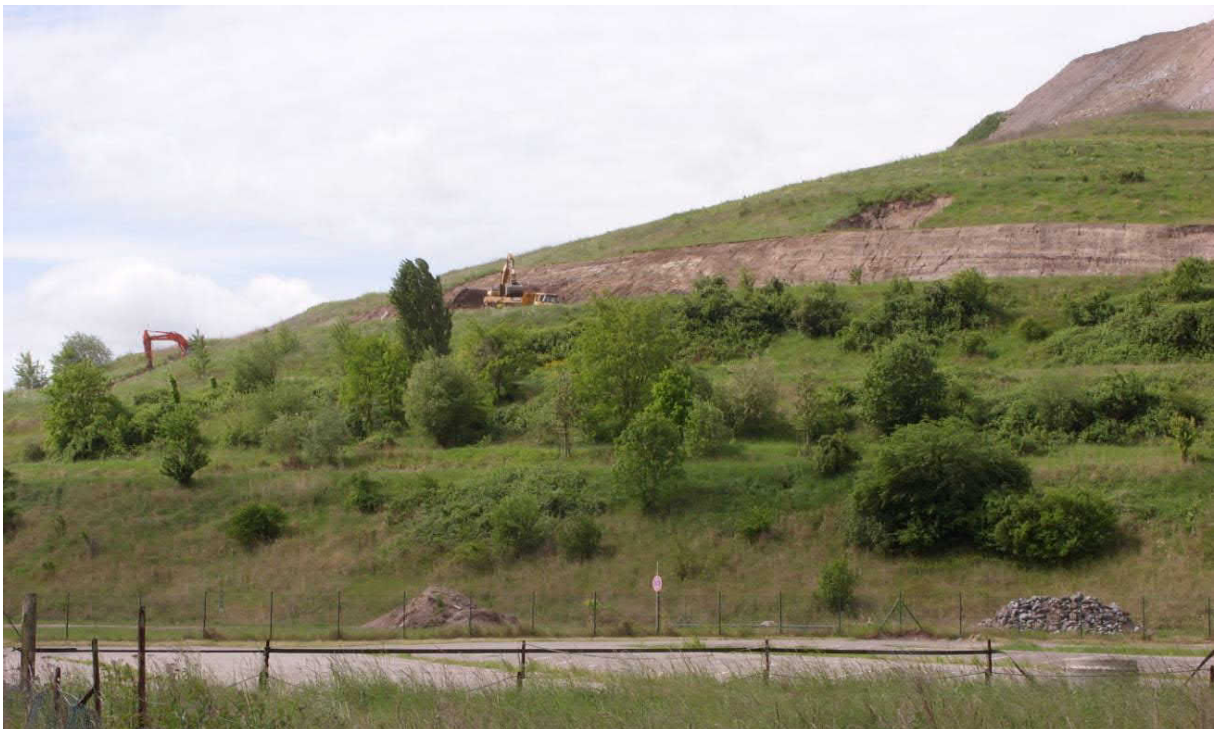
Reparatur von vier Versackungen (im Bild oben der linke Bereich mit großer Versackung ganz oben)
