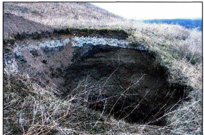
Tagesöffnung der Versackung Ost ( Bild 2 )
