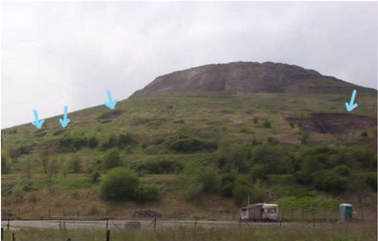
Die Pfeile weisen auf die Versackungen Anfang 2017
